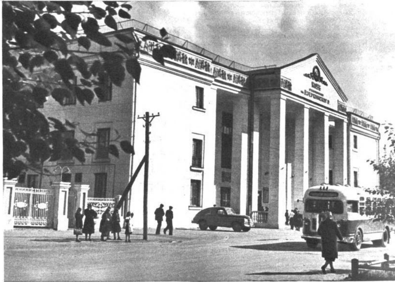
Клуб стекольного завода.
