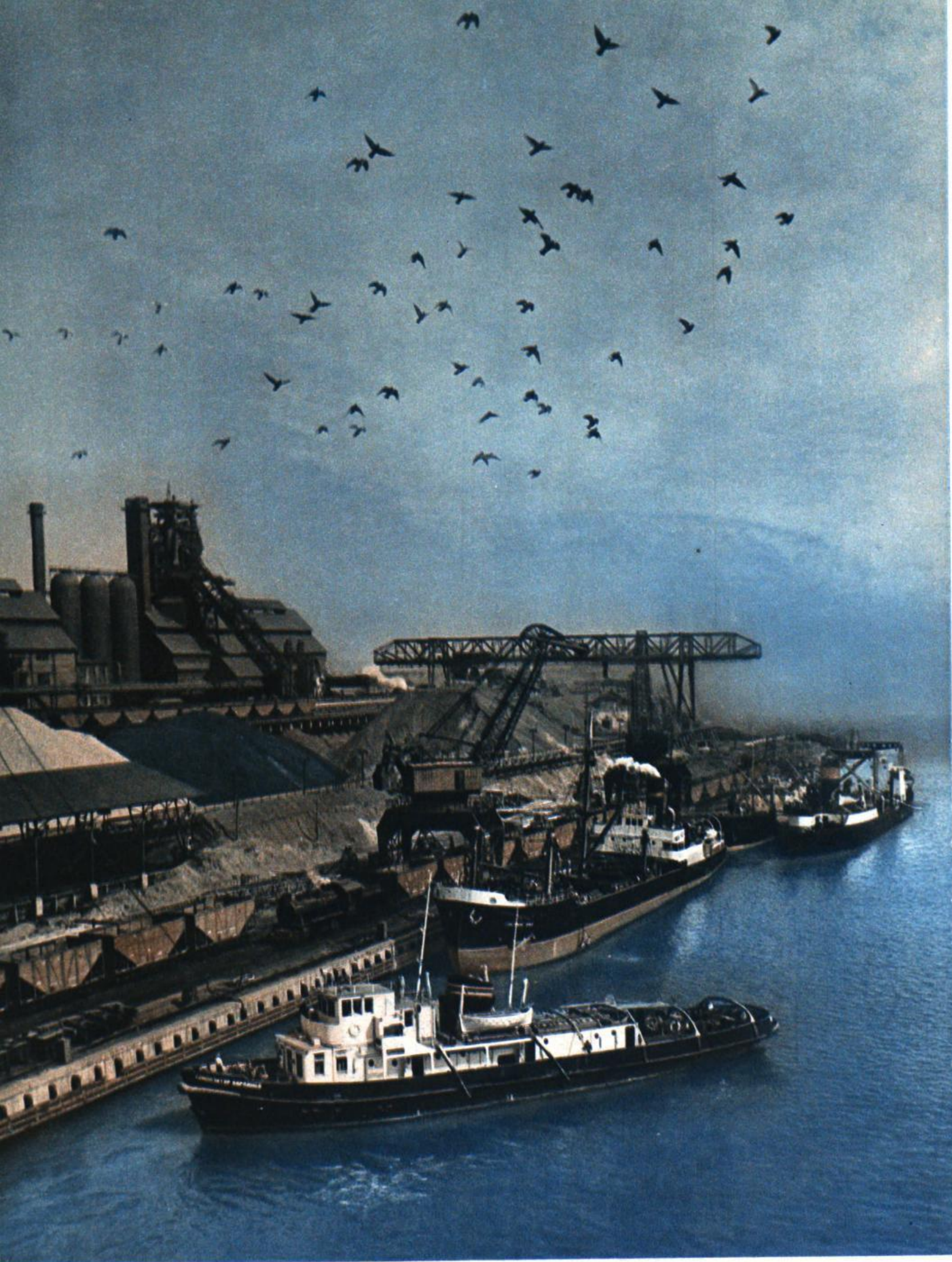
Город Жданов. Порт завода «Азовсталь» имени С. Орджоникидзе. Разгрузка пароходов с камыш-бурунским агломератом для доменных печей завода.
